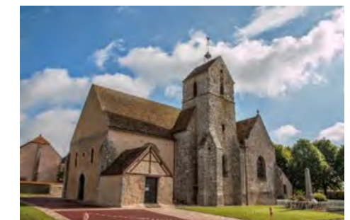
PHOTO 4 - EGLISE SAINT-MARTIN A BEAUVILLIERS
